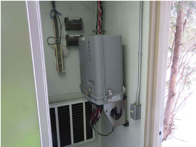
B EXISTING RAYCAP JUNCTION BOX IN SHELTER SCALE: N.T.S.
