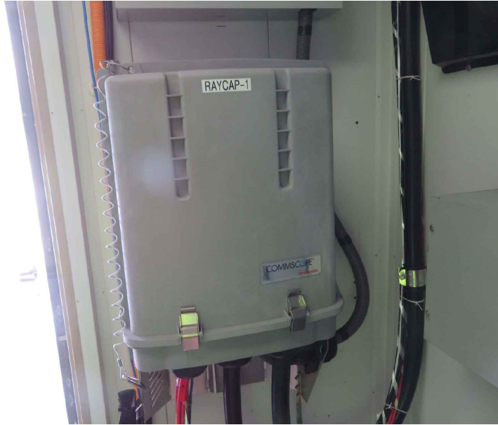
A EXISTING RAYCAP JUNCTION BOX IN SHELTER SCALE: N.T.S.
